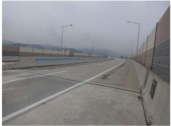
교량 상부 전경
