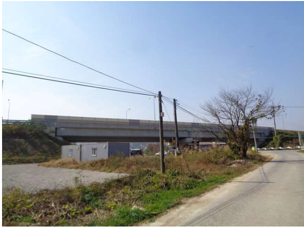
교량 측면 전경
