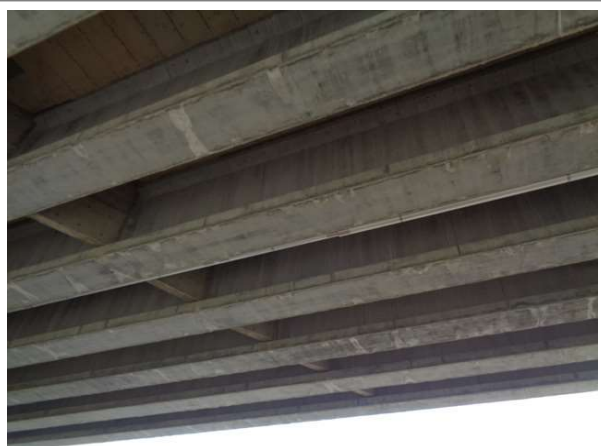
교량 거더 전경
