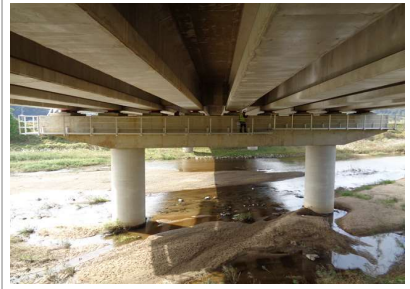
▲ 교량받침 점검로 근접조사
