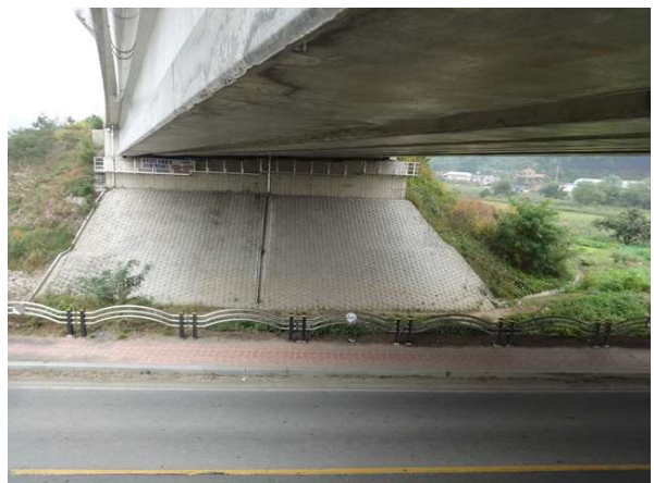
교량 하부 전경
