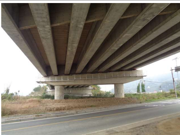
교량 하부 전경
